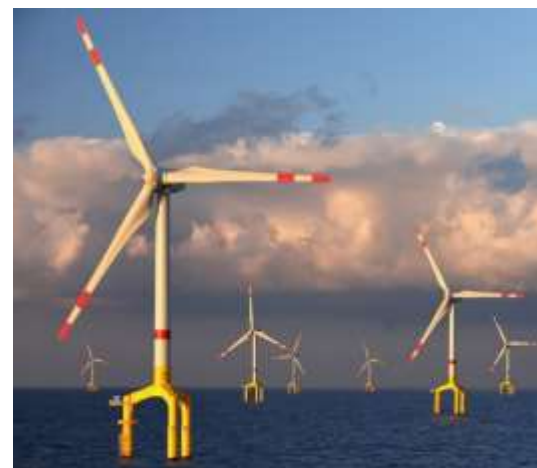
Опорные сооружения для морских ветрогенераторов BARD 5.0
